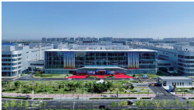
中微公司临港产业化基地
