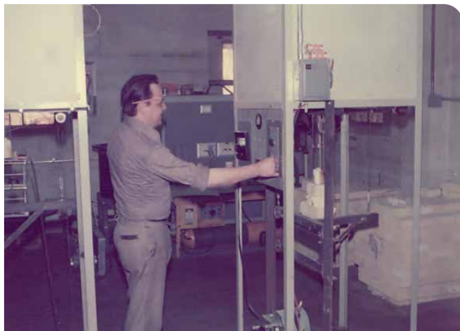
II-VI 最初租用了一家提供 5,300 平方英尺空间的前金属加工和焊接车间。公司第一年向房东支付了 2,500 美元，第二年支付了 5,000 美元，第三年支付了 7,500 美元，房东最终成为了我们创始股东集团的第十三名成员。由 II-VI 设计和建造的第一台立式布里奇曼炉，用于生产碲化镉材料。操作熔炉的是联合创始人 James Hawkey
