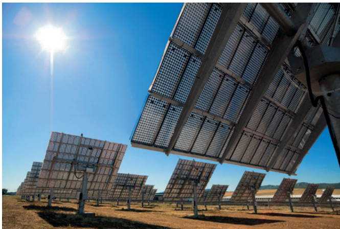
对集中光伏技术的兴趣在2008年达到了历史最高点。该领域的领导者Concentrix公司使用菲涅尔透镜，将阳光以通常500倍的倍率集中到三结电池上。然而，信贷紧缩和硅光伏价格的急剧下降对该新兴的集中光伏 (CPV) 行业造成了严重冲击。2009年，Soitec收购了Concentrix，随后在2015年将这项技术出售给了加拿大的STACE公司。
